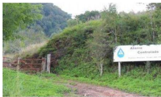
Entrada Antigo Lixão de Corupá
