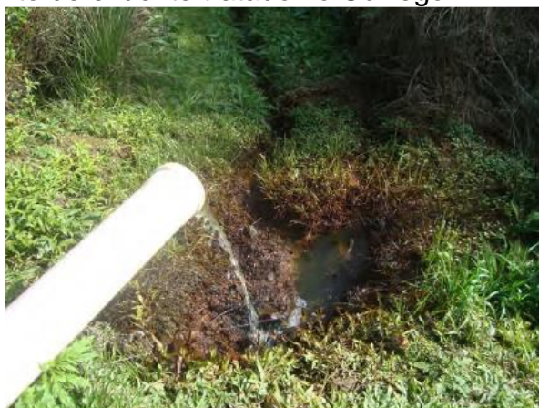
Figura 62 – Lançamento de efluente tratado no Córrego
